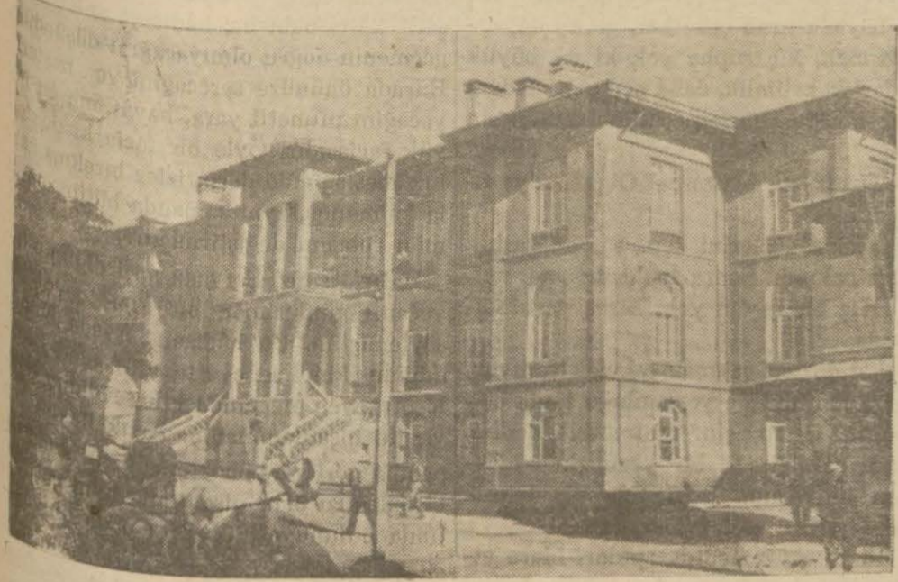
Manisa hükümet binası
